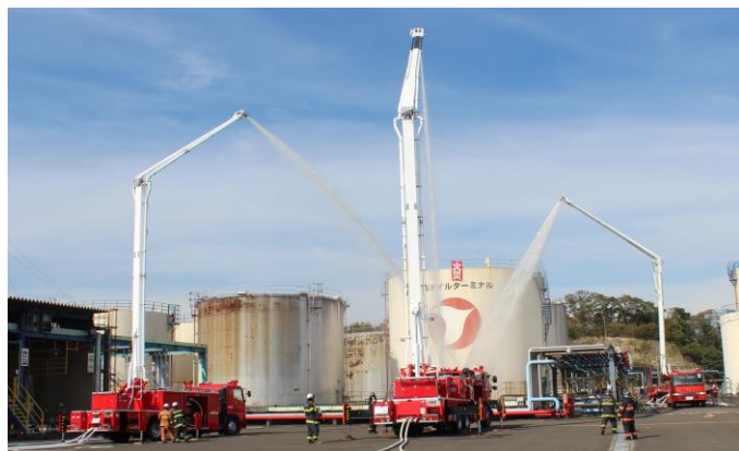
屋外タンク貯蔵所火災防ぎょ（一斉放水）
